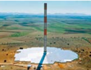
Aufwindkraftwerk Schlach Bergermann Solar, Stuttgart
